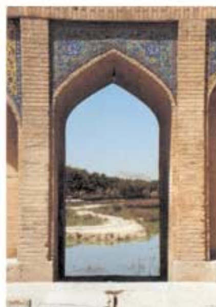
Vue du pont en amont.
